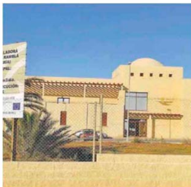
Instalaciones de Rambla Morales. LA VOZ
