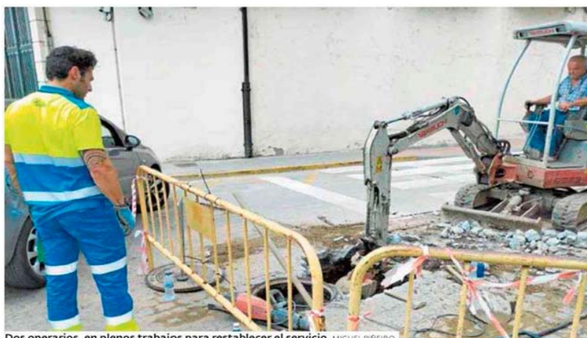
Dos operarios, en plenos trabajos para restablecer el servicio. MIGUEL PIÑEIRO
